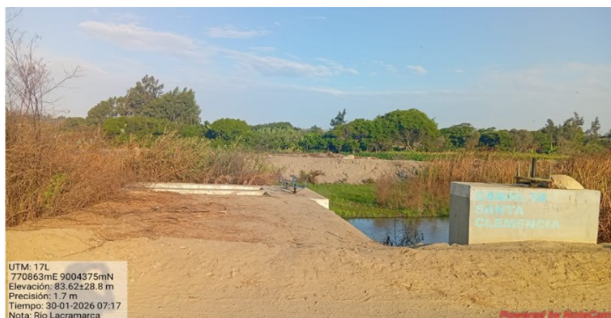
FOTOGRAFÍA N° 02: DIQUE EN LA MARGEN IZQUIERDA EROSIONADO PROPENSO A DESBORDE Y AFECTAR AREAS DE CULTIVOS Y POBLACION DEL SECTOR.
