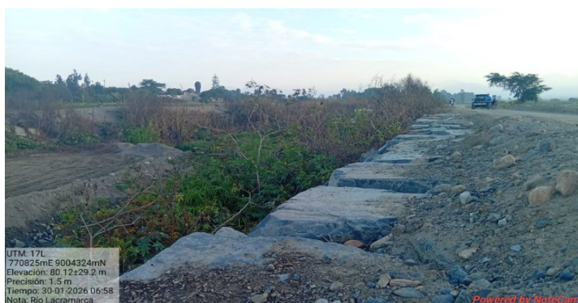
FOTOGRAFÍA N° 02: DIQUE EN LA MARGEN IZQUIERDA EROSIONADO PROPENSO A DESBORDE Y AFECTAR AREAS DE CULTIVOS Y POBLACION DEL SECTOR.
